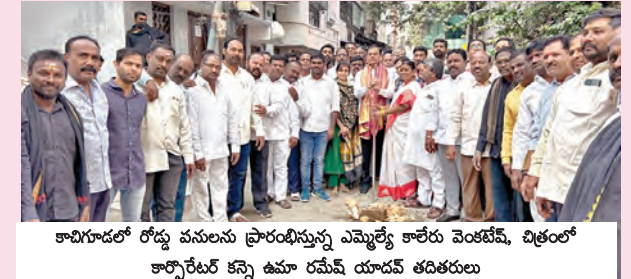
కాచిగూడలో రోడ్డు పనులను ప్రారంభిస్తున్న ఎమ్మెల్యే కాలేరు వెంకటేశ్, బిల్డర్లతో కార్పొరేటర్ కన్స ఊహ రమేష్ యాదవ్ తదితరులు
